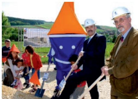
Mai 2009 Der erste Spatenstich
