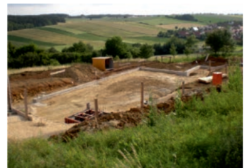
Mai 2009 Schon bald ist der Grundriss erkennbar
