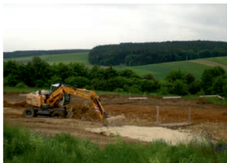
Mai 2009 Die ersten Baggerarbeiten
