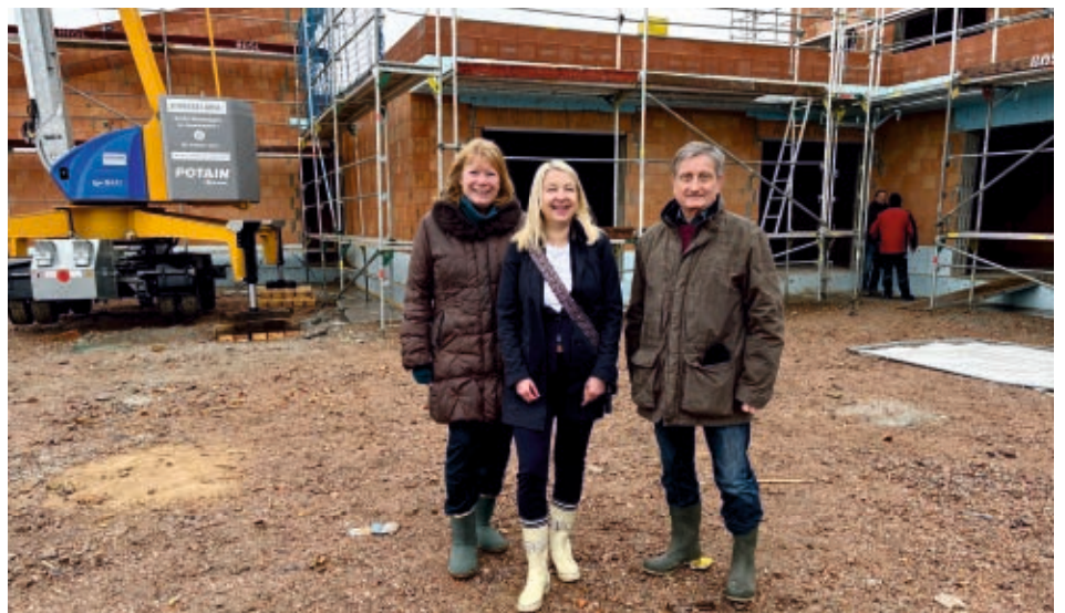
Irmgard Scherübl, Alexandra Wildner und Günther Lindner Ende Februar auf der Baustelle.
