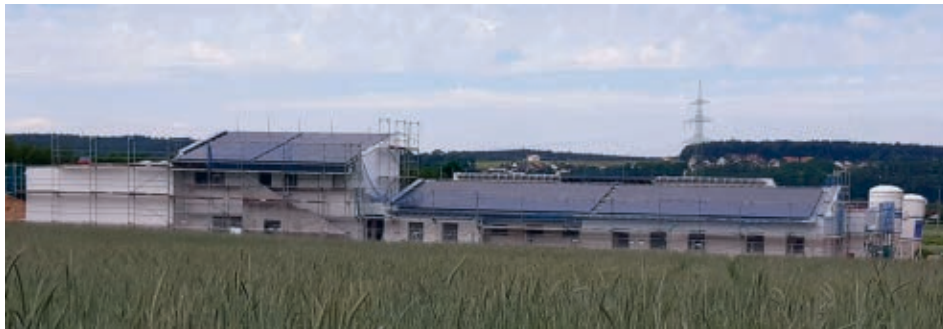
Die Ostseite des Nachsorgezentrums mit der Hausmeisterwohnung
